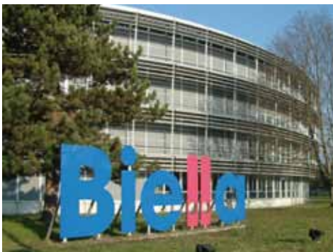
Hauptgebäude in Brügg Die folgenden Bilder zeigen die Produktion in der Schweiz.
